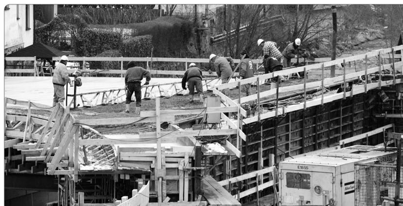
Bei Temperaturen um die Null Grad betonierten die Arbeiter die Brücke.
