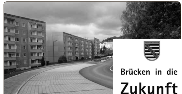
Diese Baumaßnahme wird mitfinanziert durch Steuermittel auf der Grundlage des von den Abgeordneten des Sächsischen Landtags beschlossenen Haushaltes.
