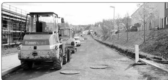
Der erste Teilabschnitt ab B 101 bis Einmündung Industriestraße wurde fertiggestellt und freigegeben. Mittlerweile wurde mit den Straßenbauarbeiten – 2. Teilabschnitt – ab Einmündung Industriestraße bis Einmündung Auer Straße begonnen. Der Abbruch der Fußwege und Börde sowie die Fräsarbeiten auf der Fahrbahn sind abgeschlossen. In die Gesamtmaßnahme werden rund 453.000 € investiert, worauf ca. 225.000 € Fördermittel entfallen.
