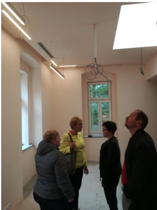
Baustelle des neuen Handschuhmuseums (Fertigstellung geplant Ende des Jahres 2018)
