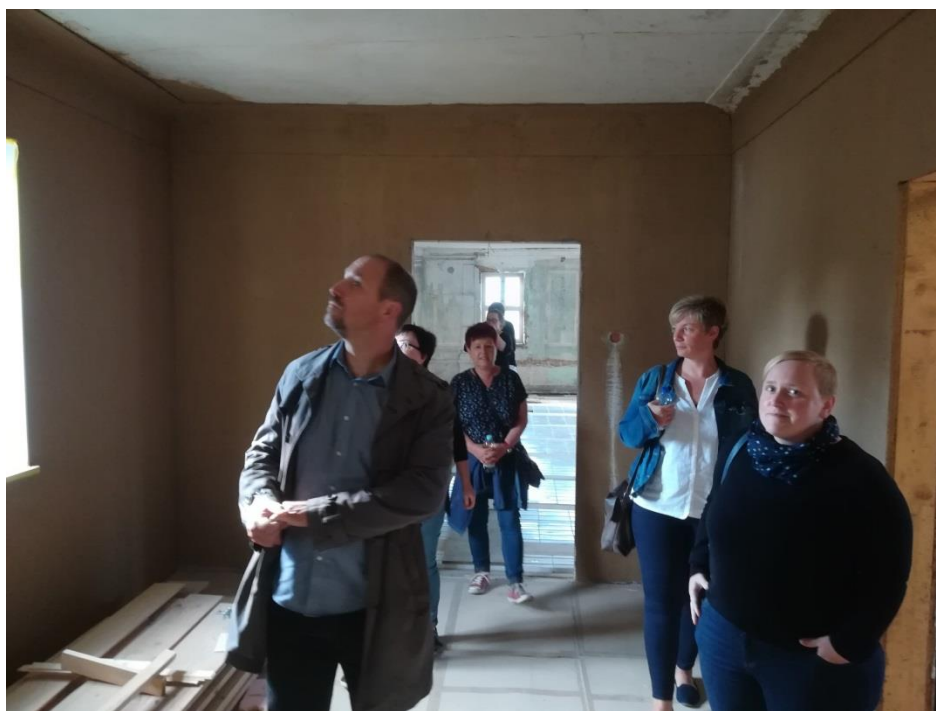
Auch der Bürgermeister von Abertamy wurde durch die Baustelle geführt
