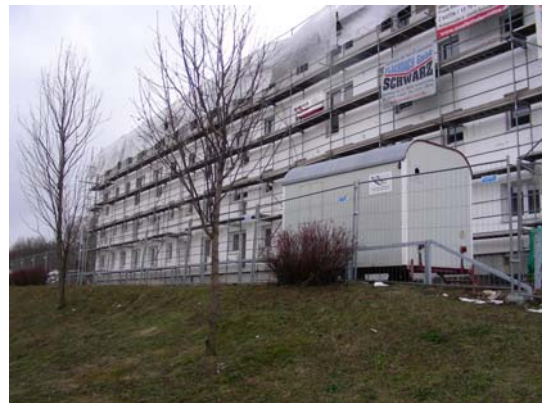
Wiesengrund 2 - 8 im Umbau, Februar 2011
