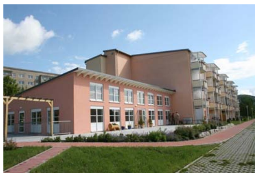
Mehrgenerationenhaus Am Fichtbusch, Fertigstellung 2008
