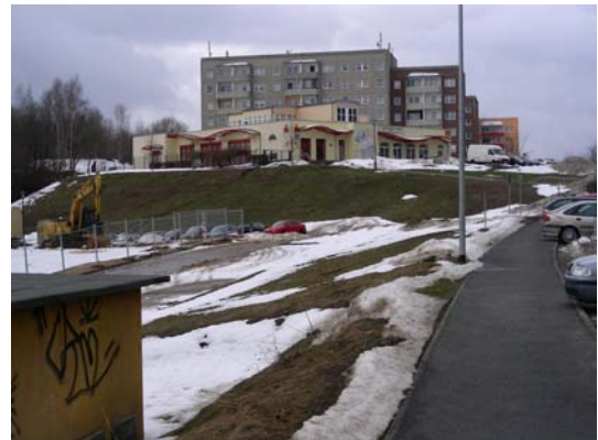
Rückbaufläche ehem. „Sachsenfelder Straße 73 - 83“, Aufhebung des städtebaulichen Zusammenhangs zum südlichen Quartier
