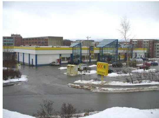
ehemalige EDEKA-Kaufhalle, jetzt teilweise leerstehend
