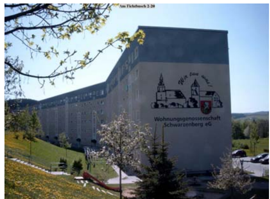
südliche Randbebauung Am Fichtbusch
