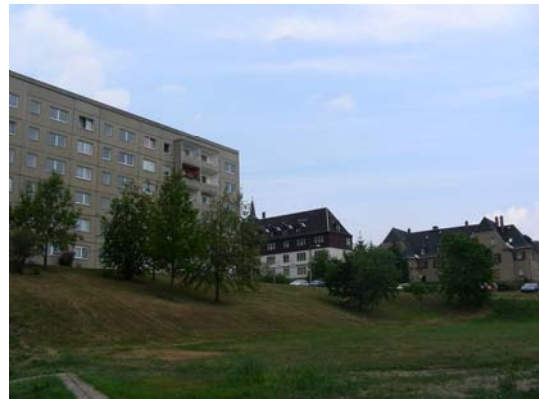
ungenutzte Rückbaufläche Sachsenfelder Straße, Abzweig Richterstraße, Zustand 2008
