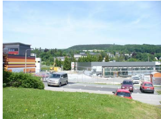
Stadtteilplatz und Schulschwimmbad im Bau, Mai 2011
