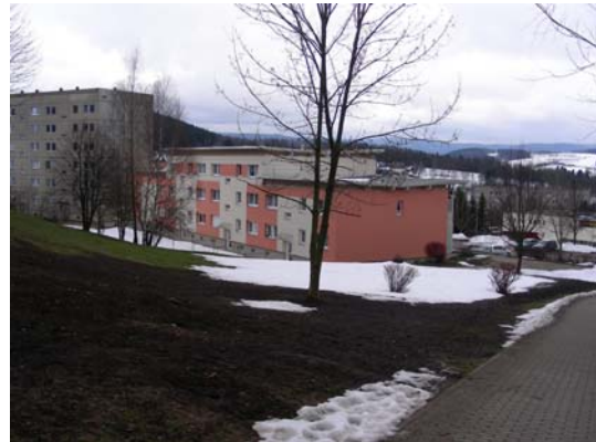
Teilrückbau Sachsenfelder Straße 29 - 35 im städtebaulichen Zusammenhang
