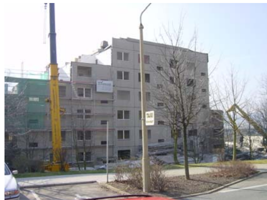
geschossweiser Rückbau des Gebäudes Am Fichtbusch 53 - 59
