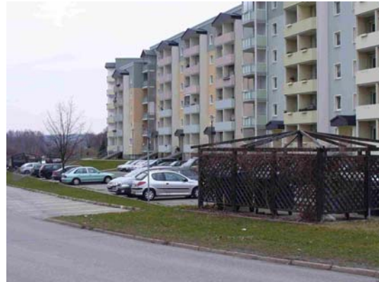
Wohngebäude Sachsenfelder Straße 1-25
