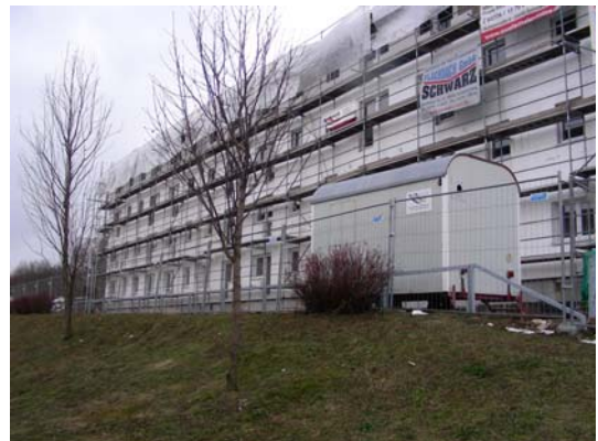
Wiesengrund 2 - 8, laufende Teilrückbaumaßnahme, Februar 2011
