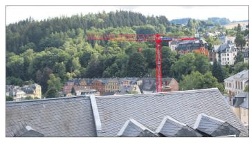
Das Parkhaus in der Schwarzenberger Altstadt nimmt mehr und Firma Goldbeck gefertigten Stahlmehr Gestalt an. Im Juli wurden stützen, Wände und Deckenplatu.a. Entwässerungsleitungen verlegt und Stützwände gesetzt. Die Fundamentarbeiten sind weitestgehend abgeschlossen und das zukünftige Treppenhaus im Rohbau aufgestellt.
